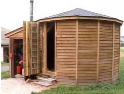
12 chaufferies de 100 kW produisant 2 500 MWh/an, à partir de bois déchiqueté local. Installation réalisée en 2015.
